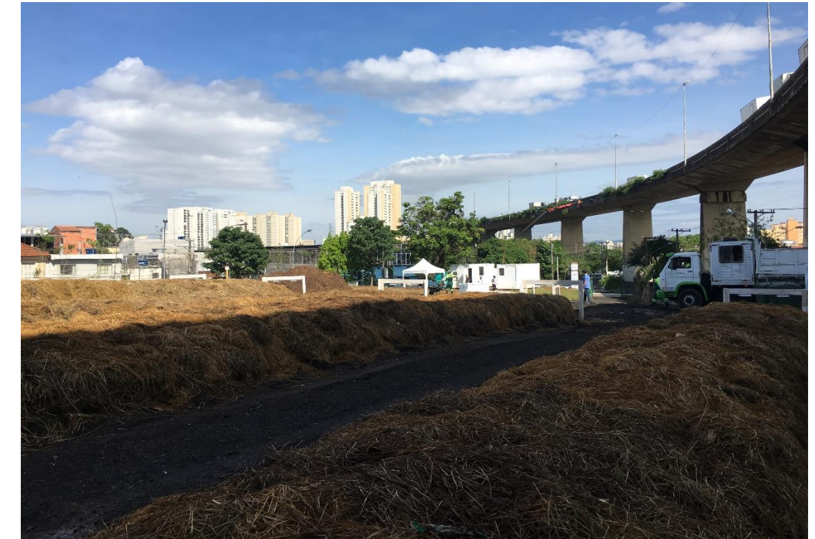
Pátio de Compostagem da Mooca
